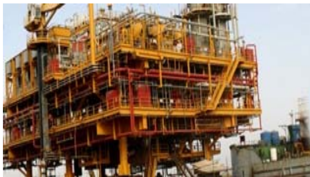
شکل ۱۸-۵ ساخت سازه و سکوها ی دریایی در خرمشهر
